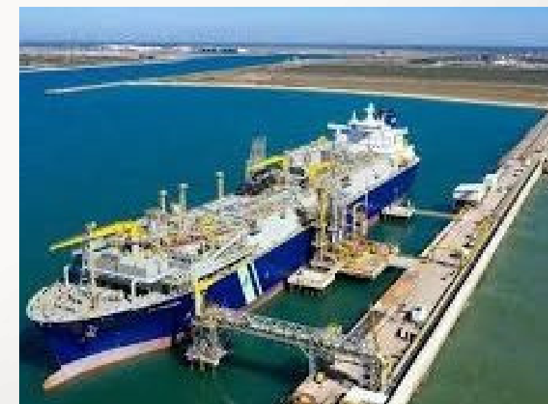
TERMINAL DE REGASEIFICAÇÃO DE SÃO PAULO (TRSP)
